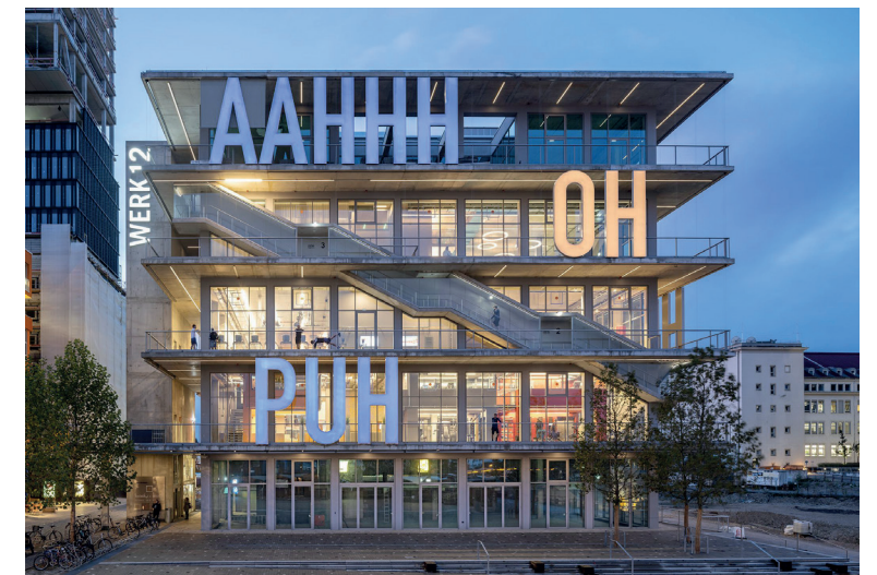
Ankergebäude als Wahrzeichen
